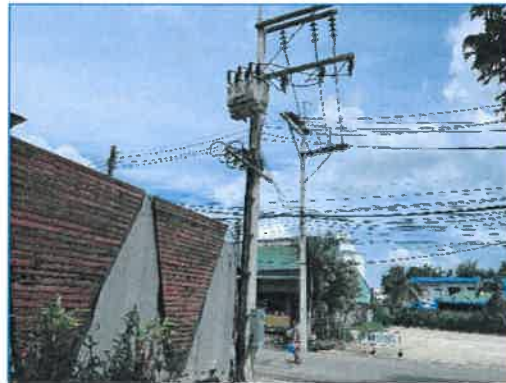
หม้อแปลงไฟฟ้าของโรงแรม
